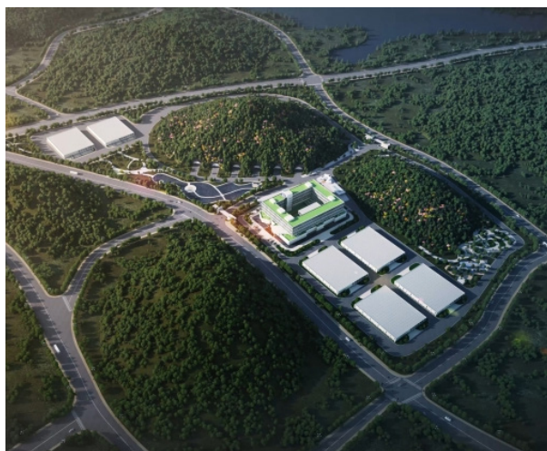
腾讯贵安七星数据中心全景图
